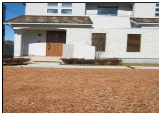
リサイクル瓦チップの施工例（住宅）
