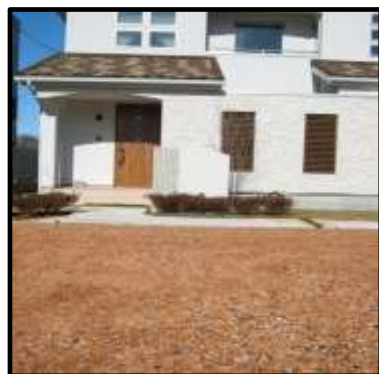
民家での施工例①
